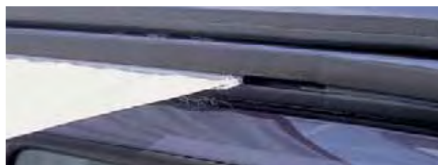
Sonnensegelbefestigung mit Einzugkeder
